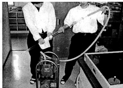
図2 ヒートパイプ内の空気を抜く作業
