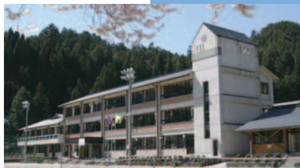
東白川中学校校舎 東濃檜を多用した3階建て 本年度はランチルームに太陽光パネルと薪ストーブが設置されました
