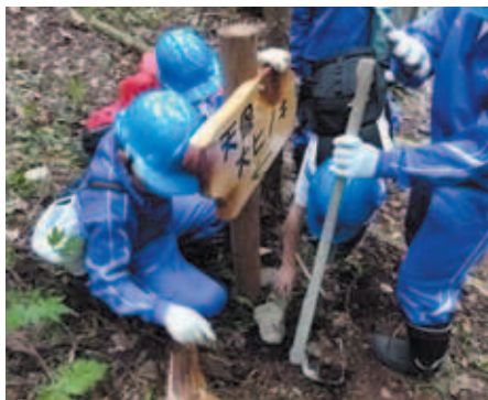
遊歩道の看板を新設
