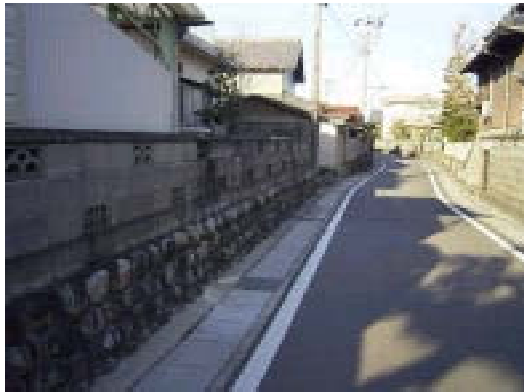
3 旧家の礎石と道路（旧道）
