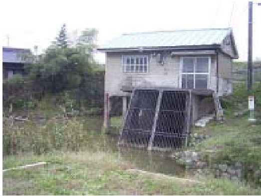
11 玄番排水樋門
